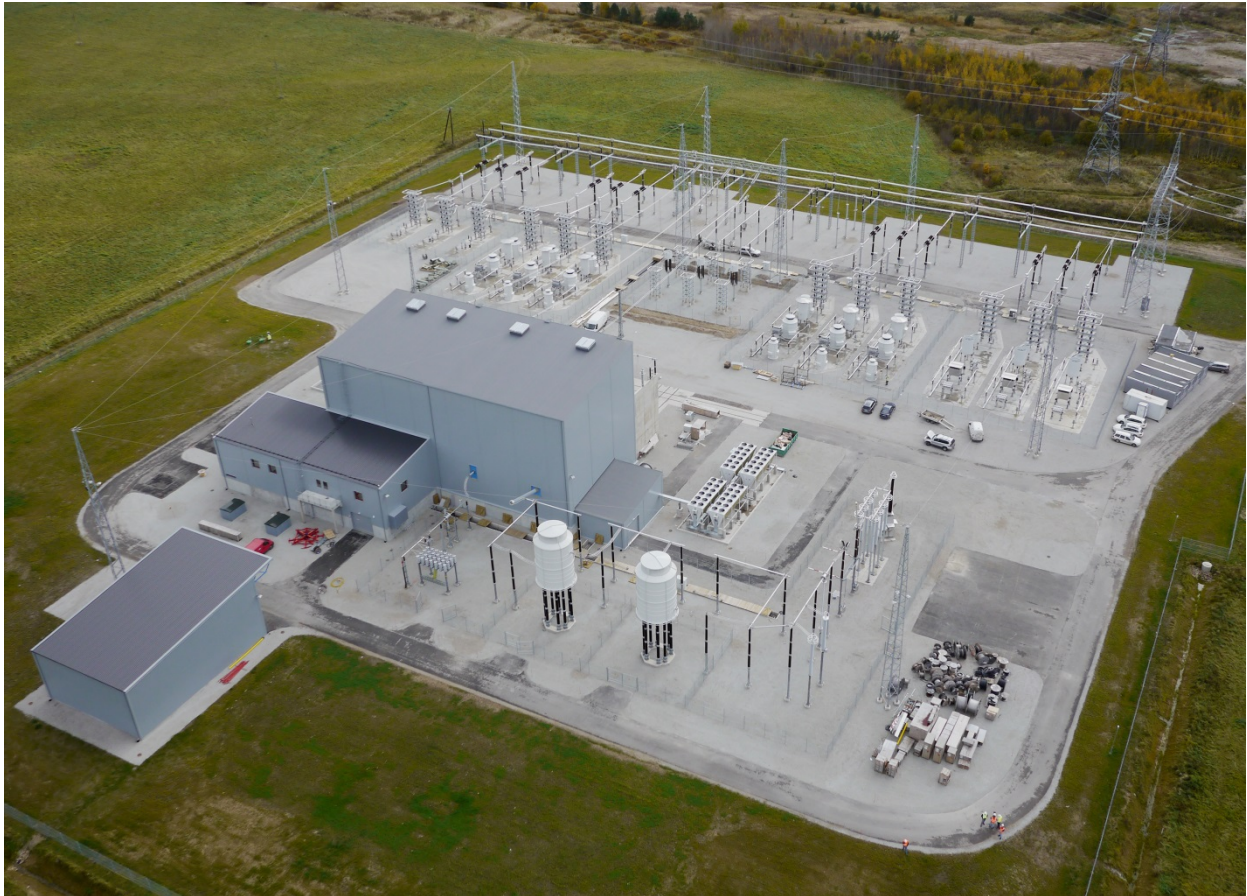
Abbildung 30: Konverteranlage vom Projekt „EstLink 2“ in Püssi, Estland (© Siemens AG (2014)).
